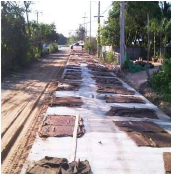
ขณะปรับปรุง - ก่อสร้าง
